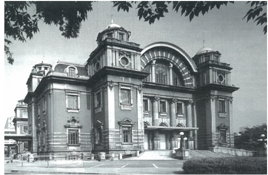
写真 5-3 免震レトロフィット (構造レトロフィット P52/建築技術)
